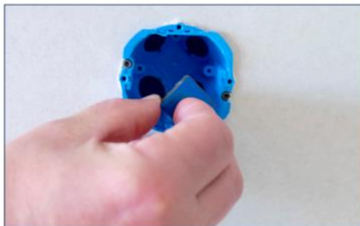
Placer brandbrikken i bunden af forradåsen, så den følger konturerne i dåsens bund.
